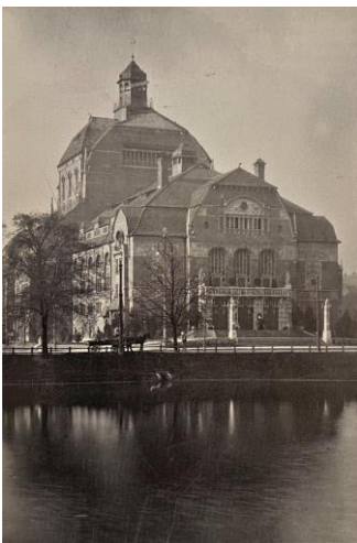
Heinrich Seeling: Stadttheater Kiel, 1907. Ansicht über den Kleinen Kiel. Foto: „Das Kieler Stadttheater (Opernhaus) 1907/1953“, Rolf Hermann Johannsen
